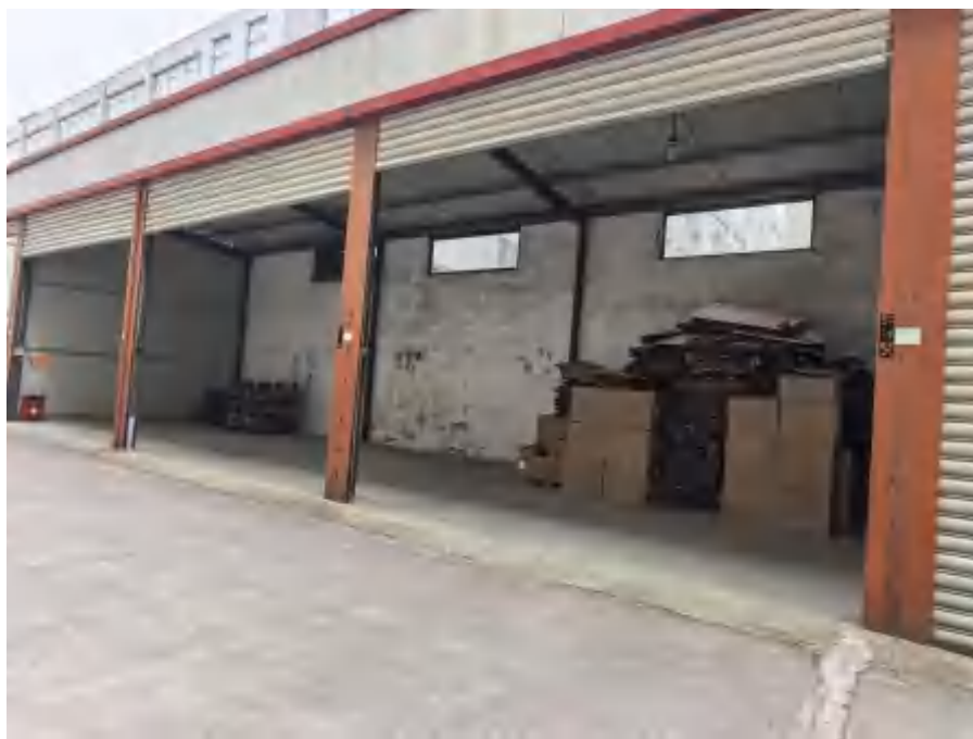
图 3-5 一般固废暂存区可回收废弃物仓库照片
